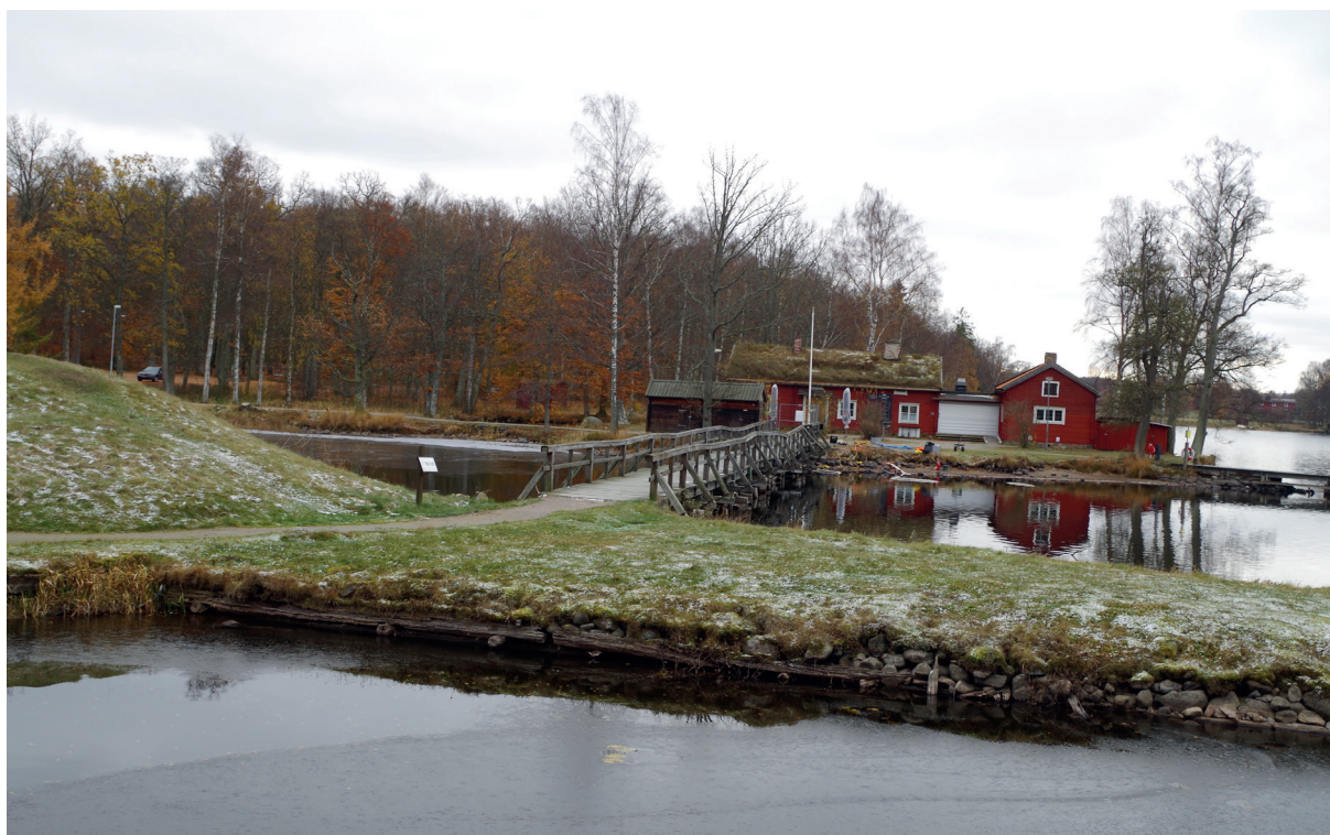
Figur 8. Nordvästra delen av Stallholmen med den tidigare bron över till Vaktholmen. Foto taget från slottsruinen i norr.
