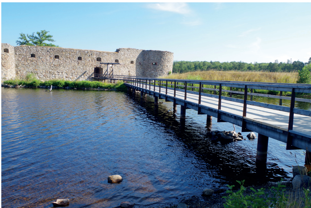
Figur 6. Den nyanlagda bron mellan Vaktholmen och Stallholmen. Foto taget från sydväst.
