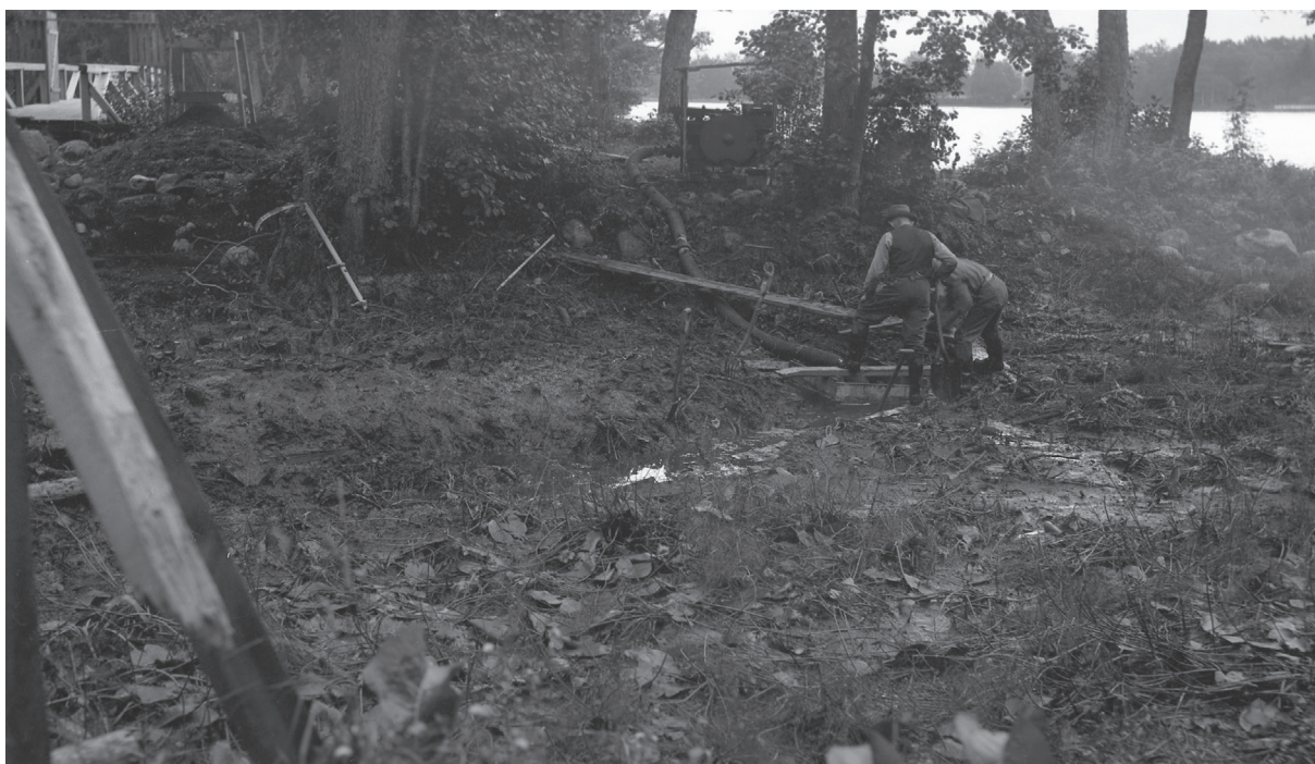
Figur 14. Foto taget när arbetet med att gräva ut vallgraven påbörjades. Foto från Bobergs arkiv, Smålands museums topografiska arkiv.
