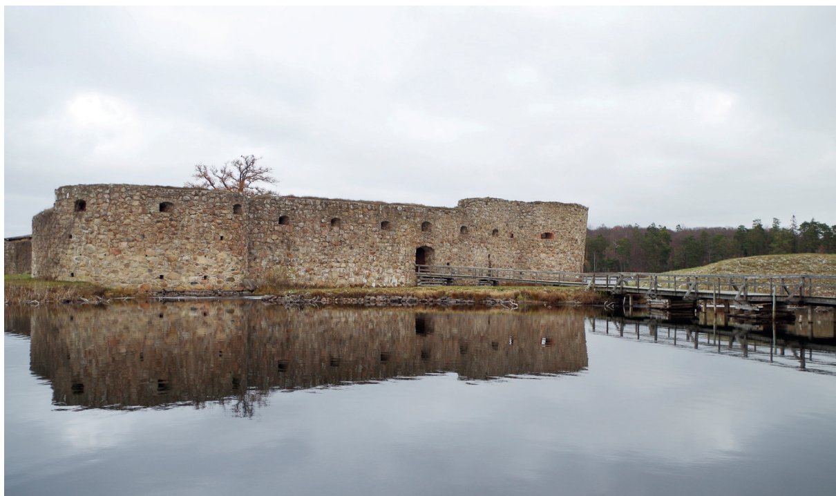
Figur 2. Kronobergs slottsruin med bron mellan Vaktholmen och Stallholmen i förgrunden och bron mot Slottsholmen i bakgrunden. Foto taget från sydväst.
