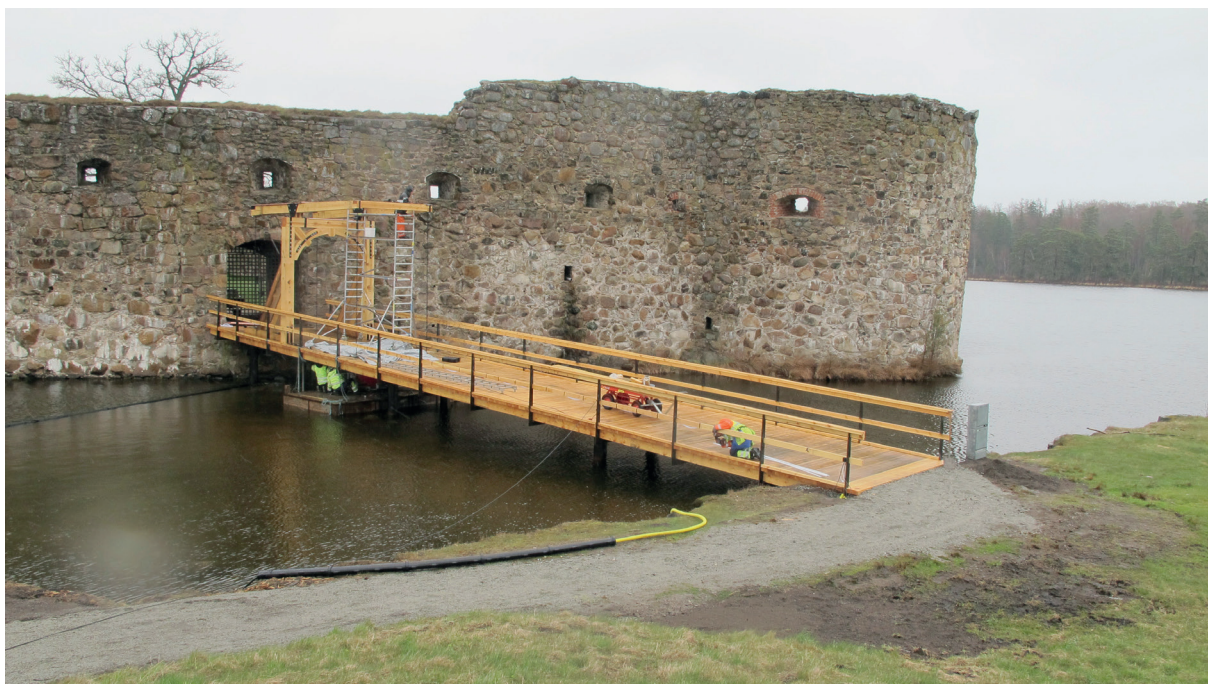
Figur 48. Den nya bron mot Slottsholmen färdigställs i april 2017 Foto taget från söder.
