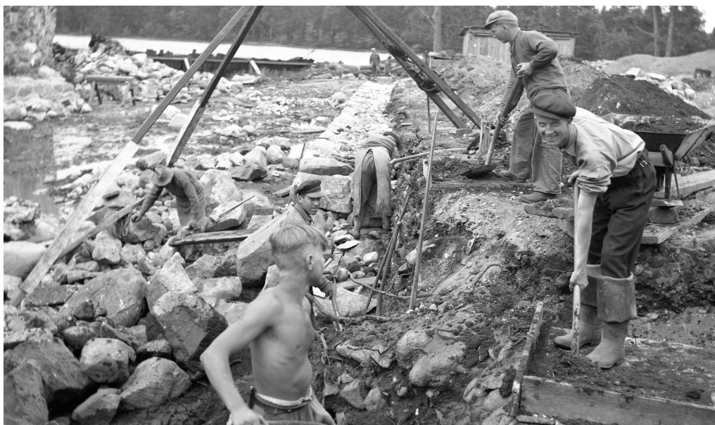
Figur 4. Kronobergs slottsruin år 1937. Bilden visar arbetet med rekonstruktionen av stenka- jen i vallgravens södra del. Foto mot öster. Fotograf: Paul Boberg (Smålands museums fotoarkiv, bild: PABO0665)
